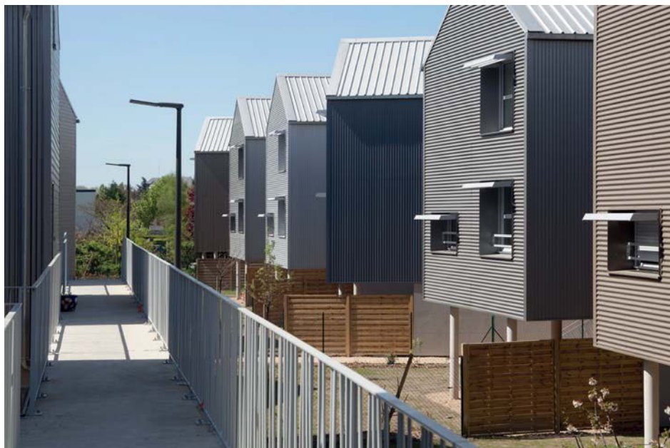
Figure D14 – Maisons sur pilotis à Saint-Pierre-des-Corps
